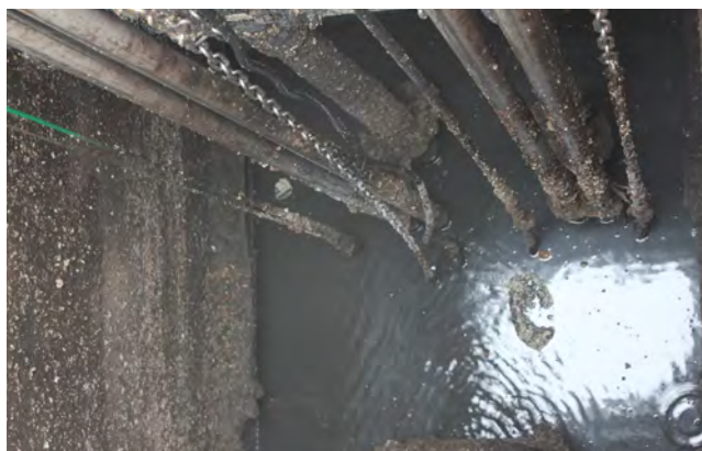
Links: Een pompput van een van onze testinstallaties voor het Flygt Concertor-systeem. Rechts: Dezelfde pompput na twee weken bedrijf van het Flygt Concertor-systeem.
